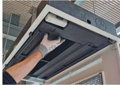
▶ Kondensatwanne abziehen.
