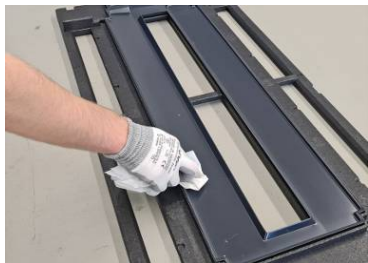
▶ Oczyszczyć wannę kondensatu.
