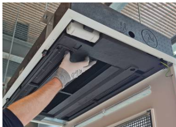
▶ Rimozione della vaschetta di raccolta condensa.
