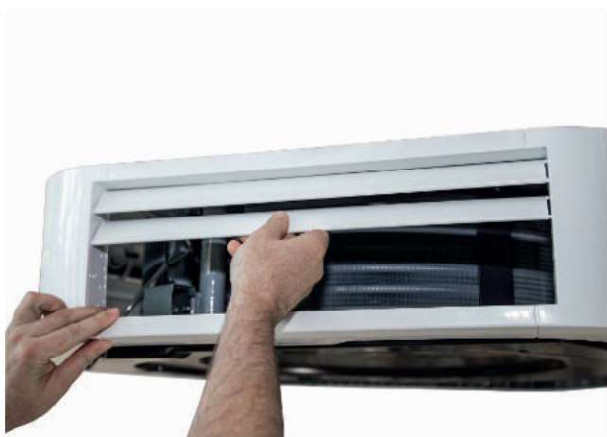
Bild 31: Demontering av fenor
