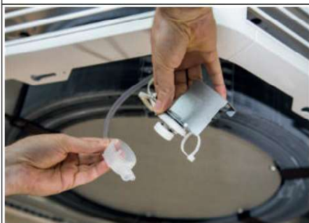
Bild 37: Demontering av locket
