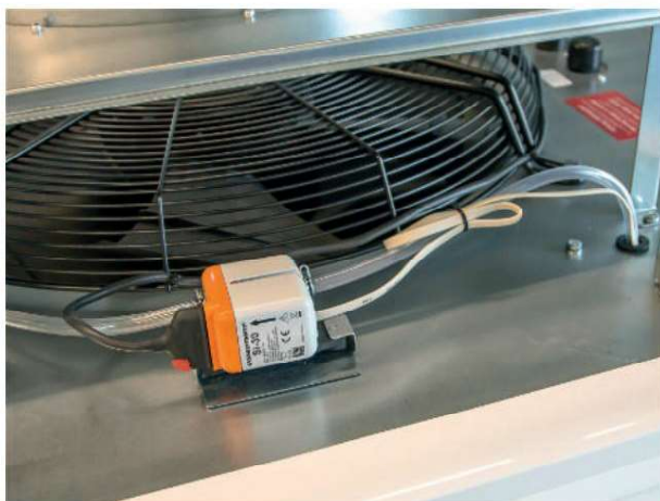
Bild 9: Kondenspump
